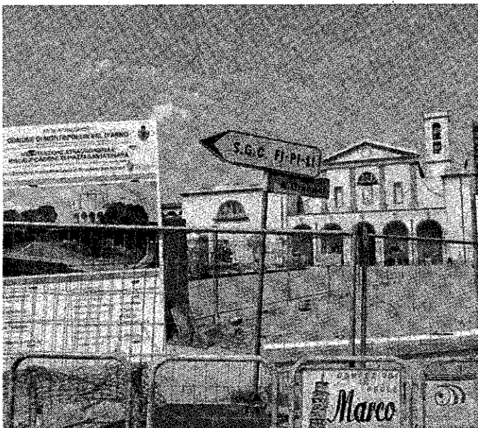
I lavori nella piazza di San Romano
